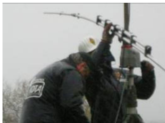
Montage van de Rotary dipol voor 40 m
